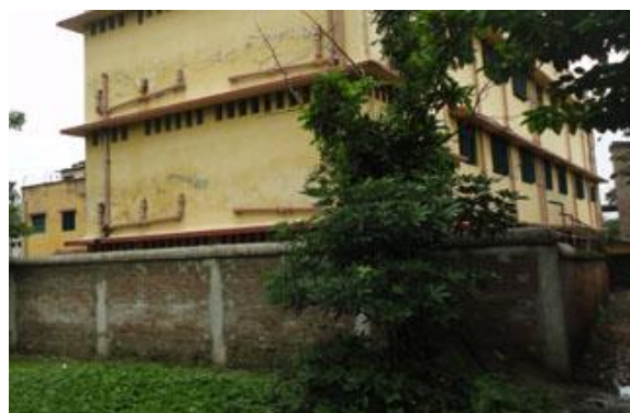
Photo du mur terminé
